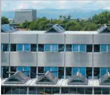
Otvori za odimljavanje
